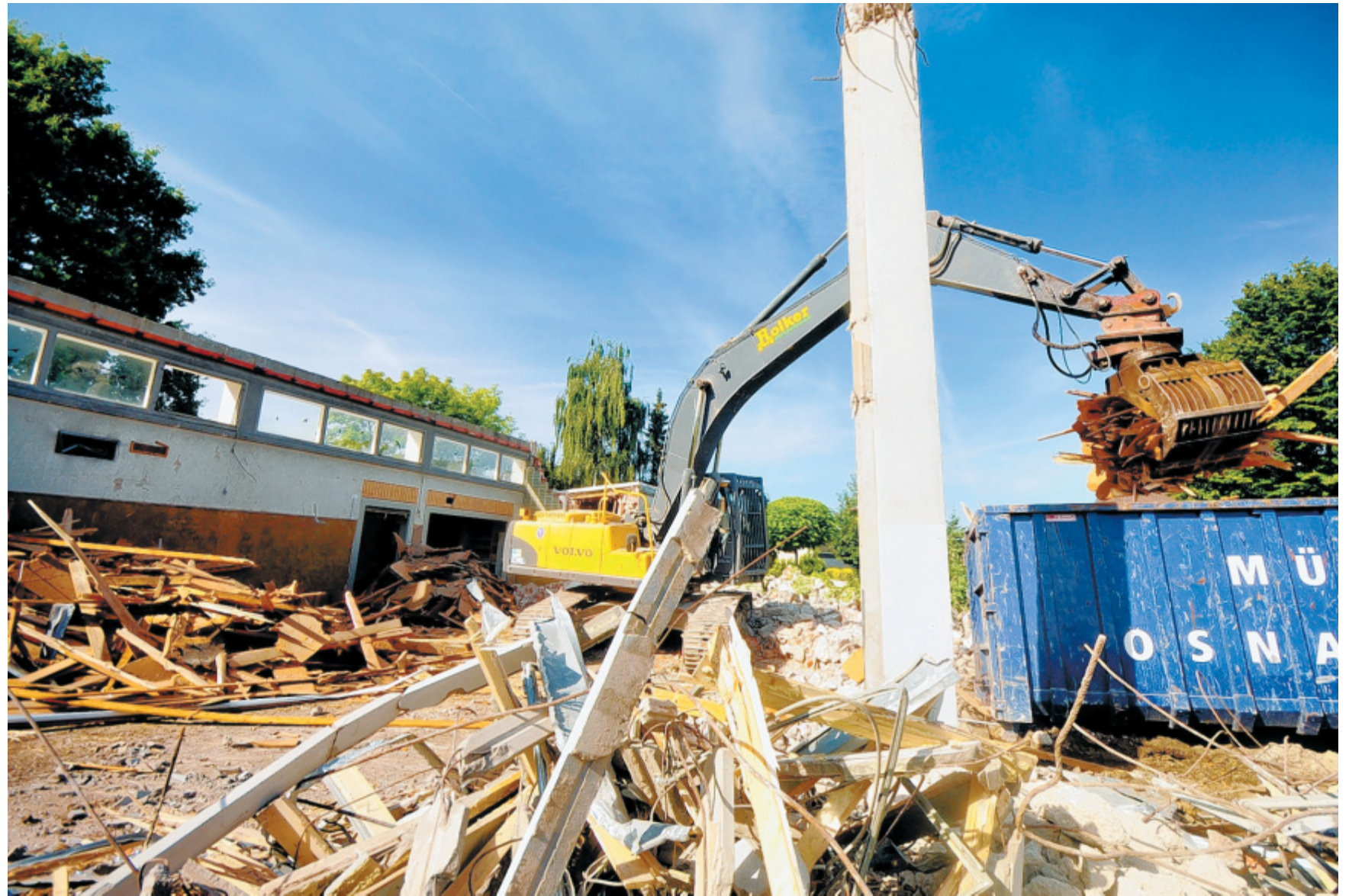
Systematischer Abbruch: Nach einem festen Ablauf wird die alte Turnhalle in Bruchmühlen dem Erdboden gleichgemacht. Der spezielle Abbruchbagger mit der wuchtigen Schaufel ist dabei das wichtigste Instrument.
